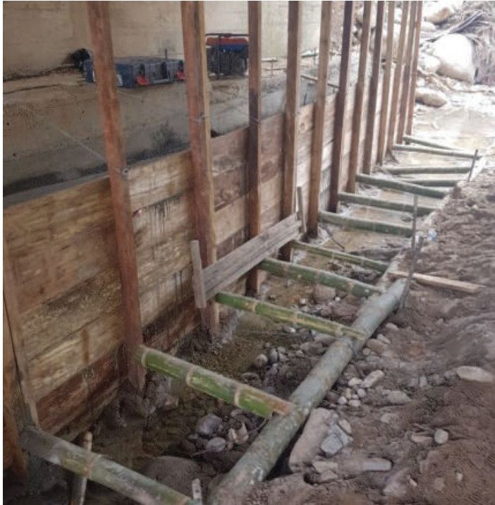
Reparación estribo Norte, Puente Mulato
