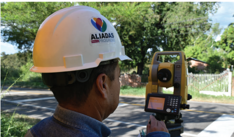
Trabajos de Topografía en el corredor vial
